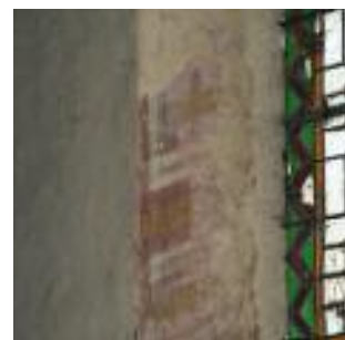
Sondage en ébrasement
