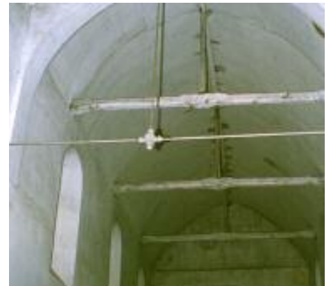
Voûte en plâtre avant restauration
