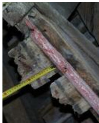
Vestige de la voûte en bois - 1398
